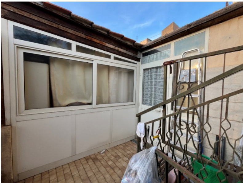
Chiusura di porzione corte esterna con copertura in legno e struttura in alluminio
