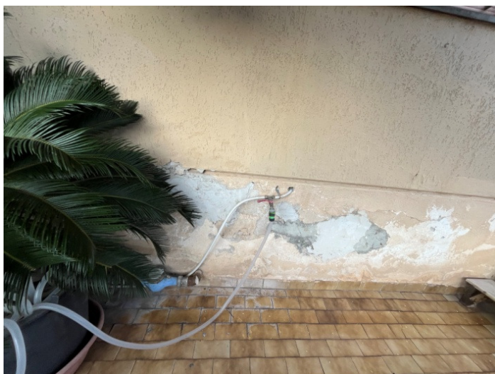
Degradì delle strutture per umidità da risalita
